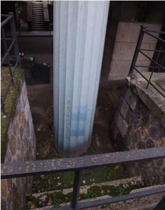
Encoche dans les murs de soutènement pour les piles du pont
